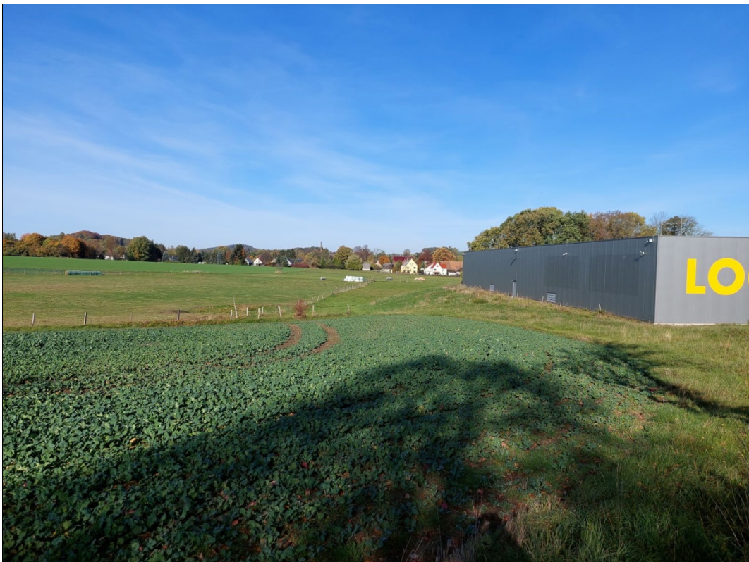
Betriebsstandort neue Lagerhalle von Neusalzaer Straße aus
